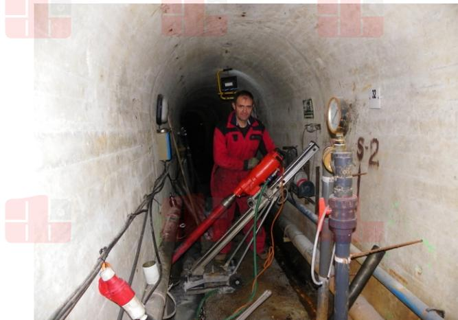
Los trabajos de perforación que ATI realiza son los necesarios para la instalación de aparatos. La cualificación de nuestros técnicos y las herramientas y utillajes diseñados en nuestros talleres, permiten realizar trabajos en galerías de presas o pilas de compuertas donde las máquinas de perforación convencionales no pueden acceder hasta el punto de realizar taladros de 50 metros de profundidad con una inclinación de 45° en galerías de 1,5 metros de ancho por 2,2 metros de alto.
